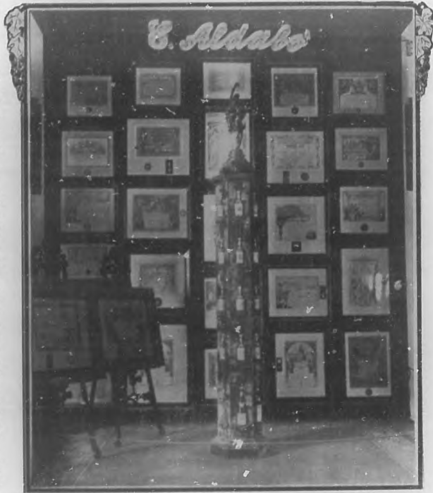
INSTALACIÓN DE LA FÁBRICA DE LICORES DE ENRIQUE ALDABÓ
